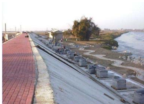
圖 1-4 下游河堤與淤灘生態工程整治
